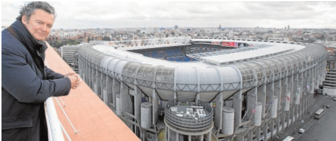
López-Chicheri se asoma a una azotea con vistas al estadio del Real Madrid
